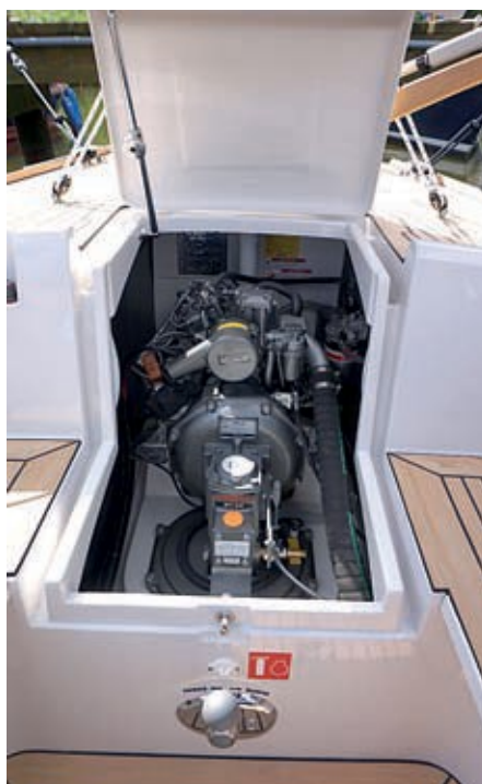
Der Diesel wird „verkehrt“ herum im Achterschiff eingebaut.
